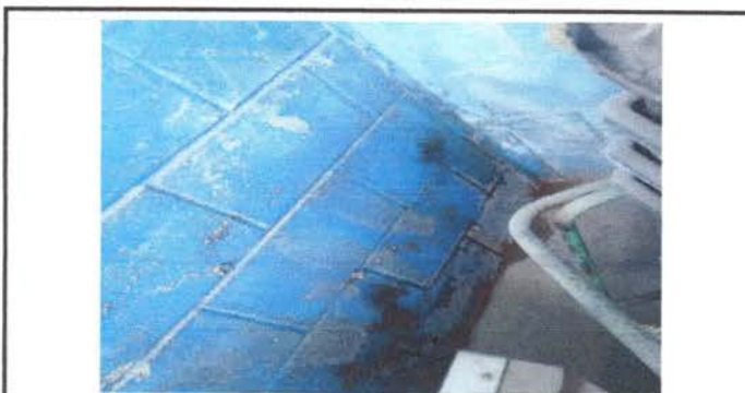
Foto 5: repello en muro
