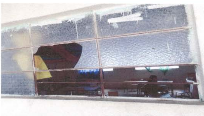
Foto 4: sustitucion de ventanas mas vidrios
