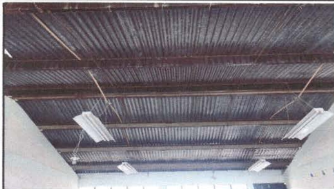
Foto 1: Sustitucion de lamparas Tripold
